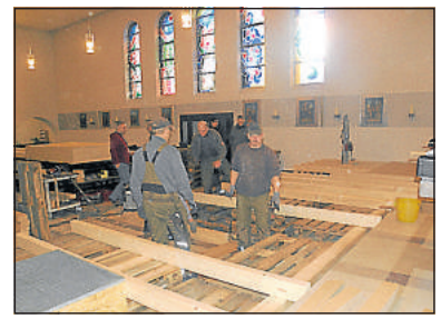
Durch die Kirchenfenster fällt stimmungsvoll Licht, während die Arbeiten vorangehen.
